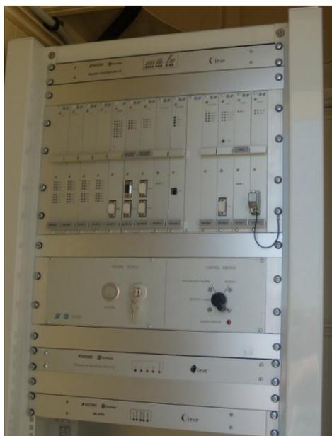
Diseñado bajo normativa Cenelec y con un nivel de seguridad SIL-4, se adapta a cualquier programa de explotación en todo tipo de configuraciones (plenas vías y diferentes tipos de afectación), para los diferentes sistemas de protección B, C y F.
